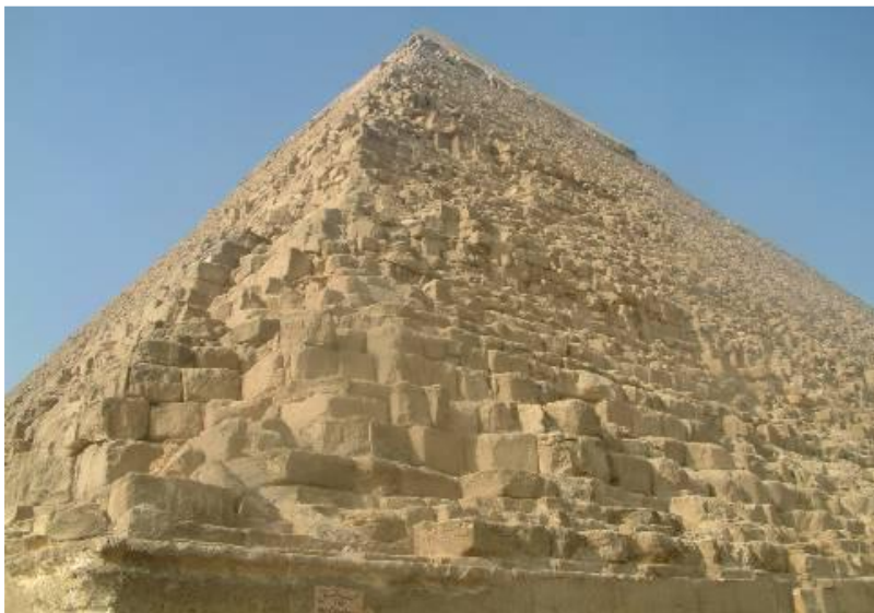
Slika 1- Kefrenova piramida -Giza - Kairo-Egipat, suvo zidanje kamenim blokovima
